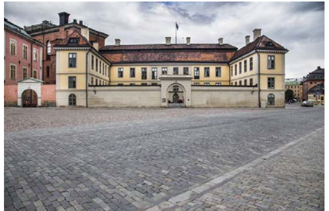
Hessensteinska palatset, Riddarholmen. Foto: Statens Fastighetsverk
